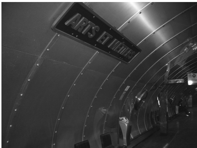
Fig. 4. Interno laminato della stazione
